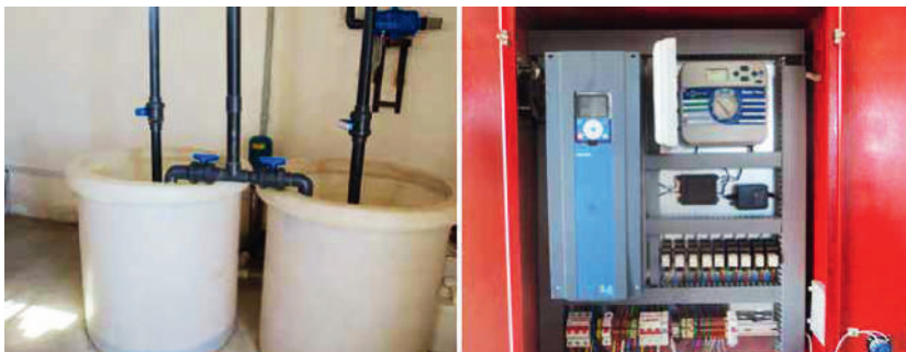
19-расм. Ўғитловчи мослама ва сугориш тизимини бошқариш учун автомат қурилма
